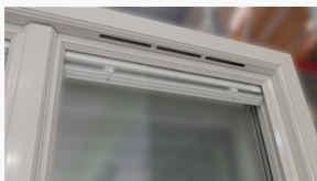
Utsidan Fräsning för ventilen i Epokkarmen visas på bilden. På samma sätt för Royalkarmen. Dvs dolt luftintag för Epok- och Royalmodellen.
